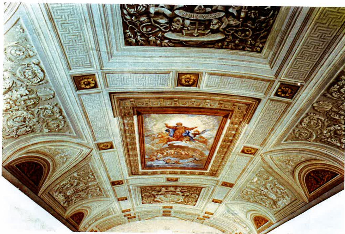
La splendida volta riportata alla luce e restaurata
