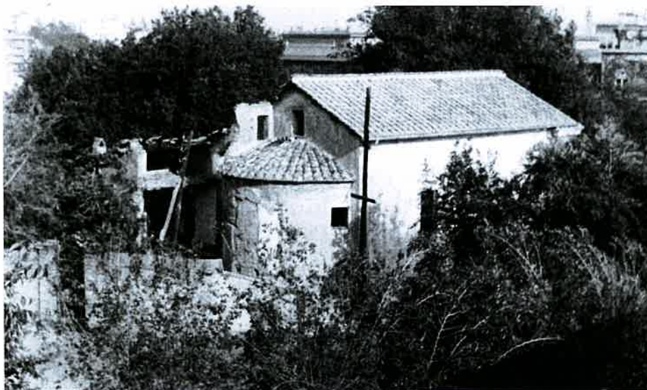
Una veduta della Chiesetta in pieno degrado
